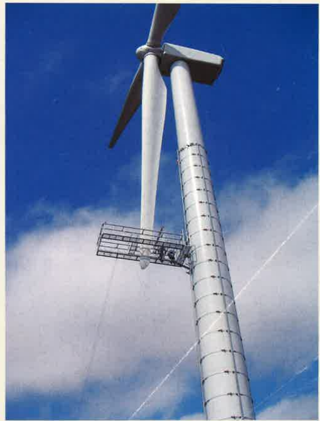
メンテナンス装置による作業状況
